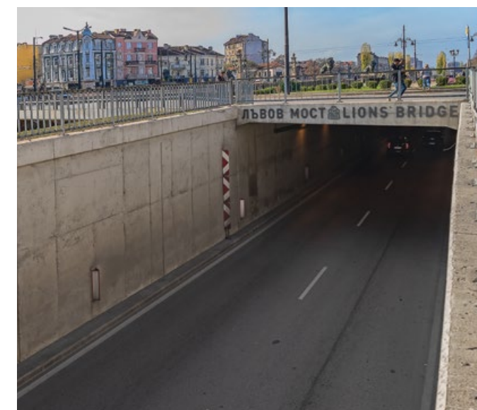
Лъвoв мост, гр. София Обем: 7 000 m³ Класове: C20/25, C25/30, C30/37, C35/45 Dmax12
